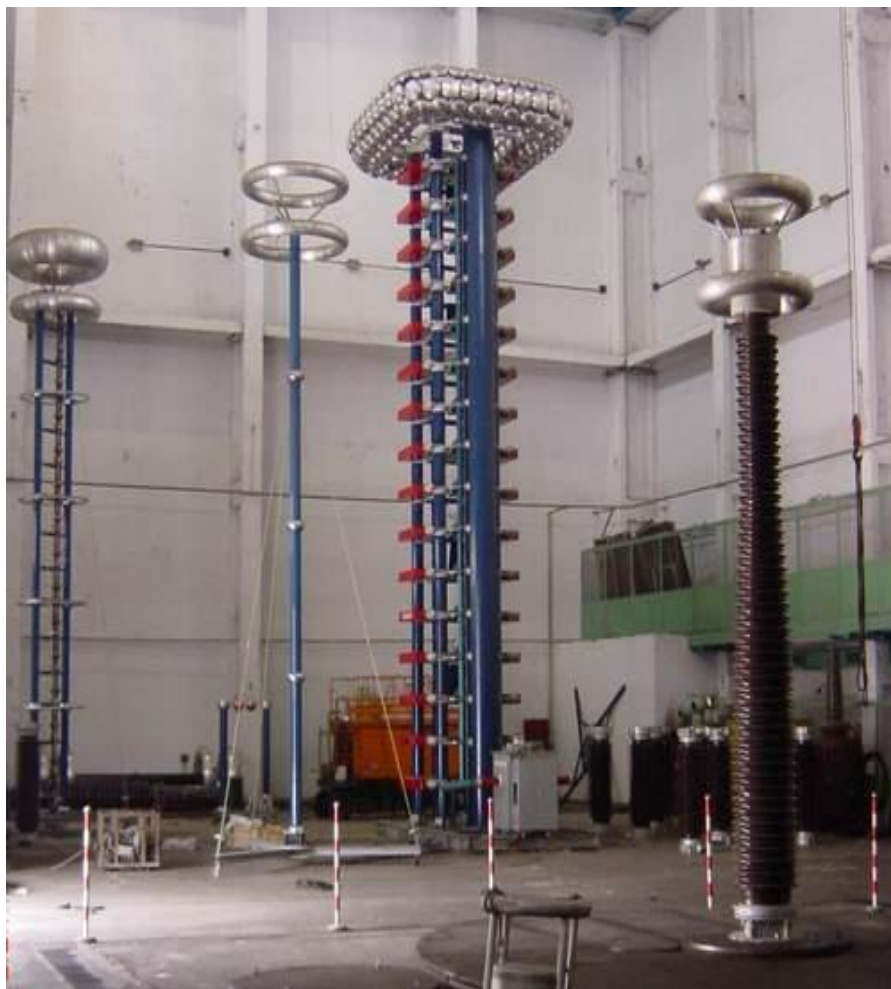
图3 3200kV冲击电压试验系统
